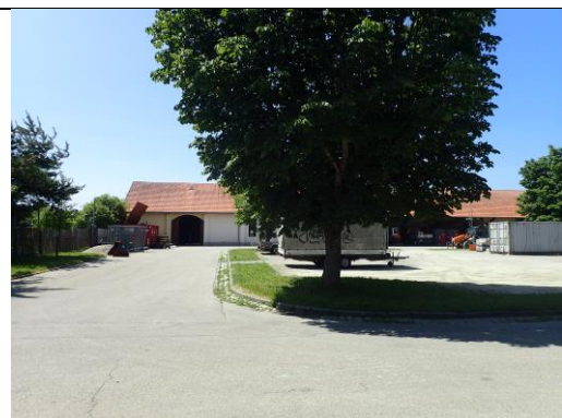
Abbildung 11: Blick auf hofseitige Gebäudeseite für Fahrzeuge und Lager Quelle: Aufnahme (PV München, Juli 2023)
