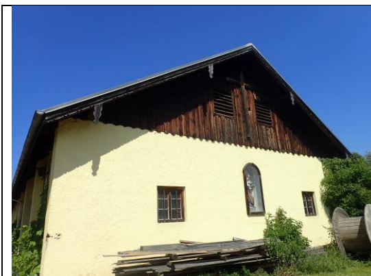
Abbildung 10: Blick auf Westgiebel des Gebäudes für Fahrzeuge und Lager Quelle: Aufnahme (PV München, Juli 2023)
